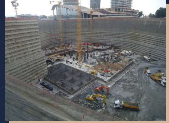
Temel Kotuna İnilmesi
