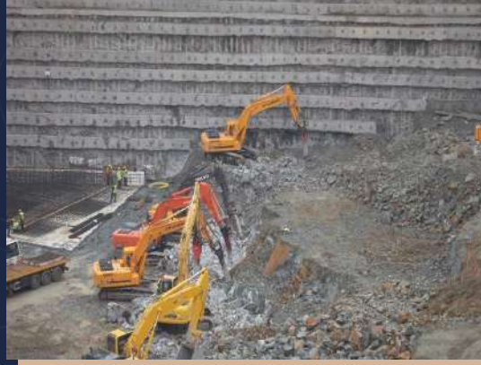
Sert Kayaçların Kırımı (Delme)
